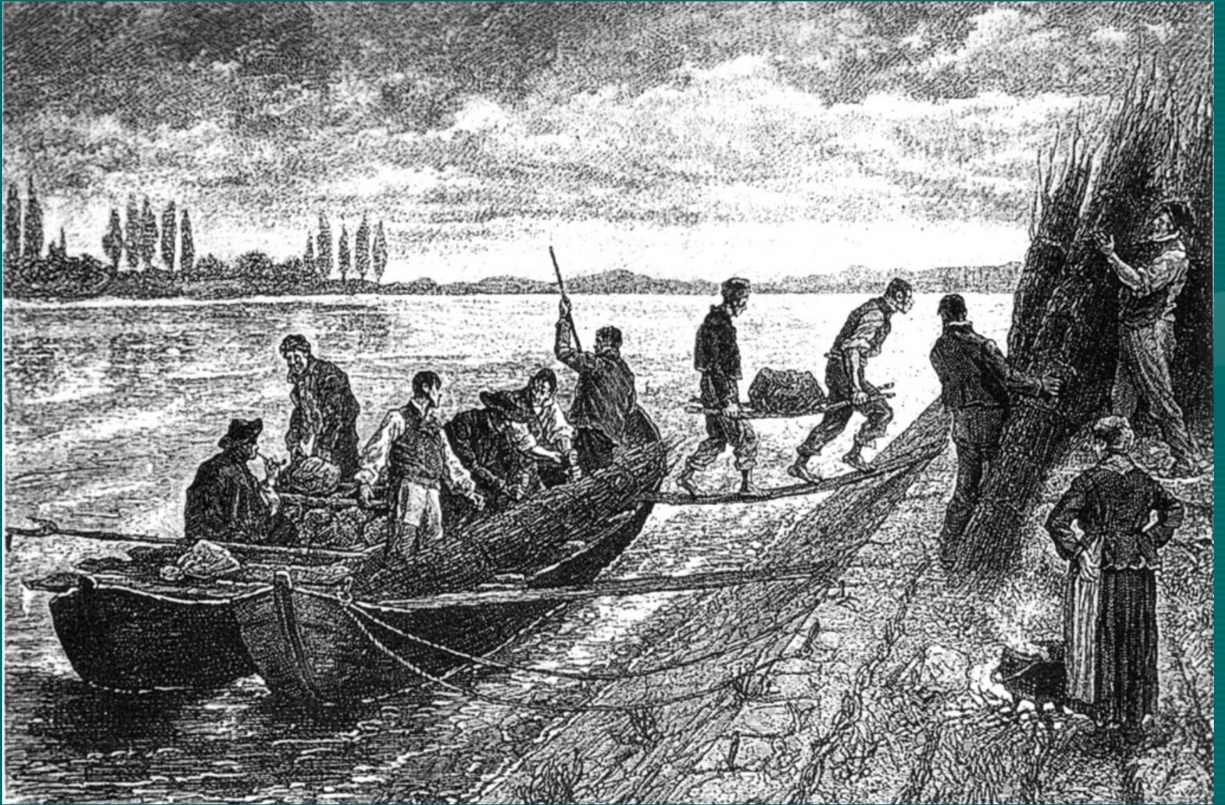
Travaux de correction près de Plobsheim (Grad 1889)
